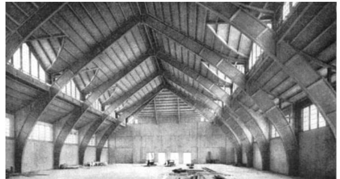
Bild 9. Ausstellungshalle der Internationalen Bauausstellung Leipzig, später genutzt als Halle in Wilhelmshaven, Spannweite 25 m, Binderabstand 6,25 m, Querschnittshöhe 1,1 m, Herstellung und Montage in 4 Wochen, 1913 [12]
