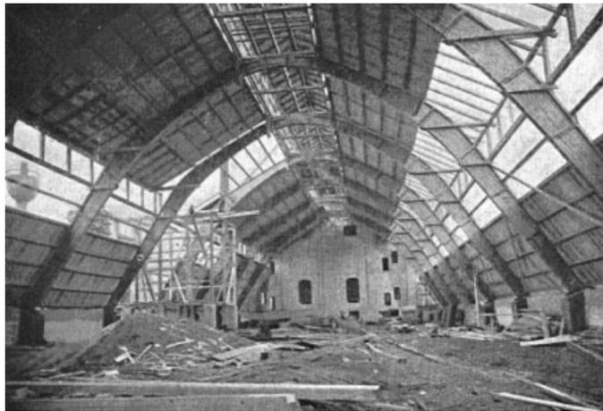
Bild 6. Rohsalzschuppen für das Kaliwerk Steinförde, Spannweite 22,5 m, 1910 [5]
